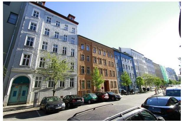
Blick Visavis Schönholzer Straße 2013
